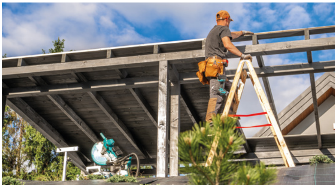
Figura 7.3 – Diagnóstico y mantenimiento de la madera preservada
