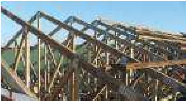
*Ilustración 33: Unión placa dentada en cercha
