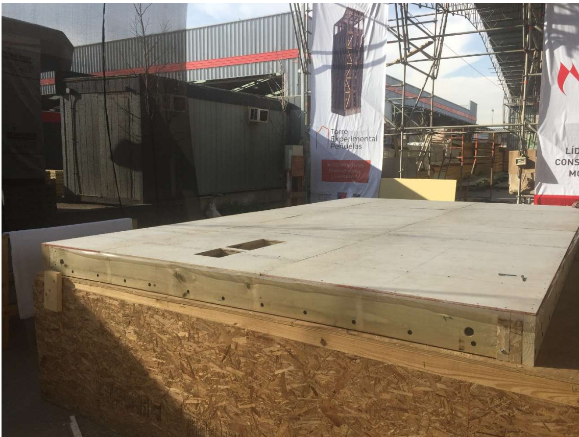
Fotografía 2: Fabricación de entramado de losas
