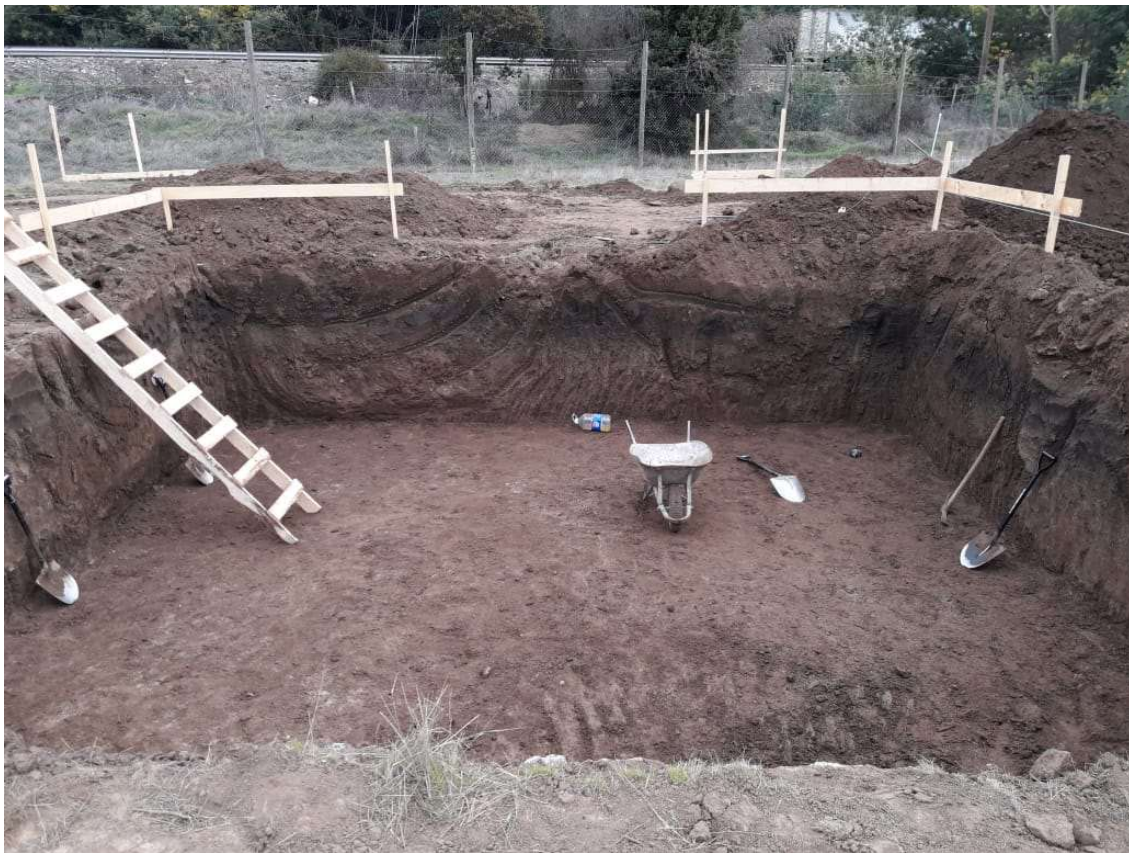
Fotografía 5: Sello de fundación de edificio principal.
