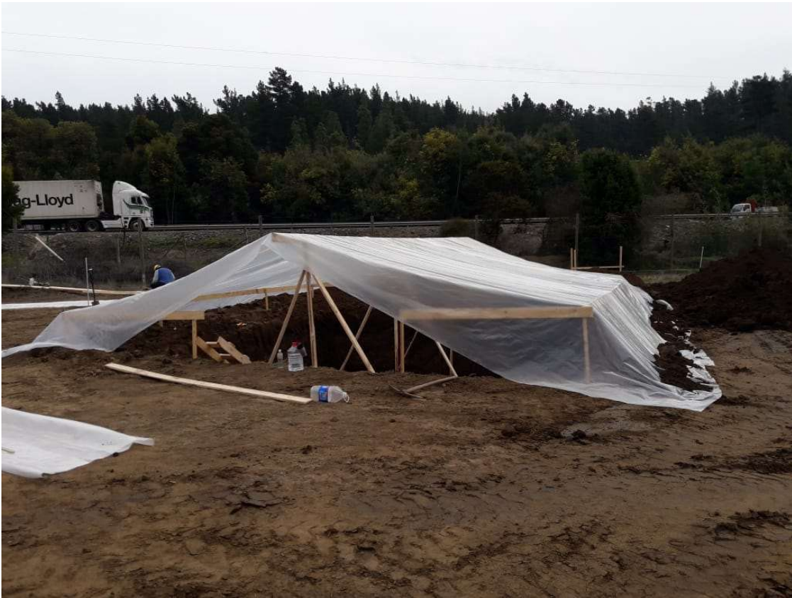
Fotografía 4: Excavación en proceso, cubierta por mal clima.
