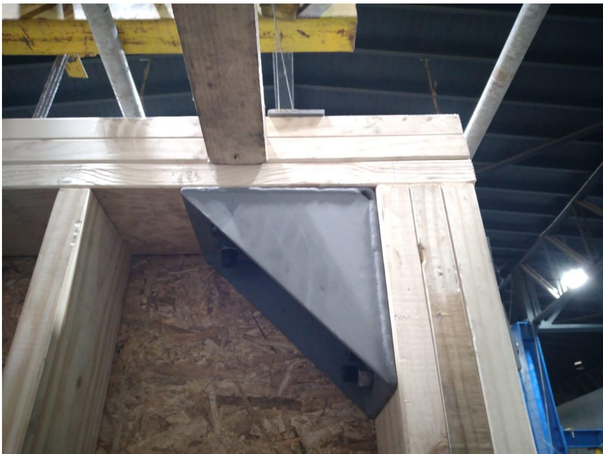
Figura 2. Ángulo de acero en esquina cuerda/colector.
