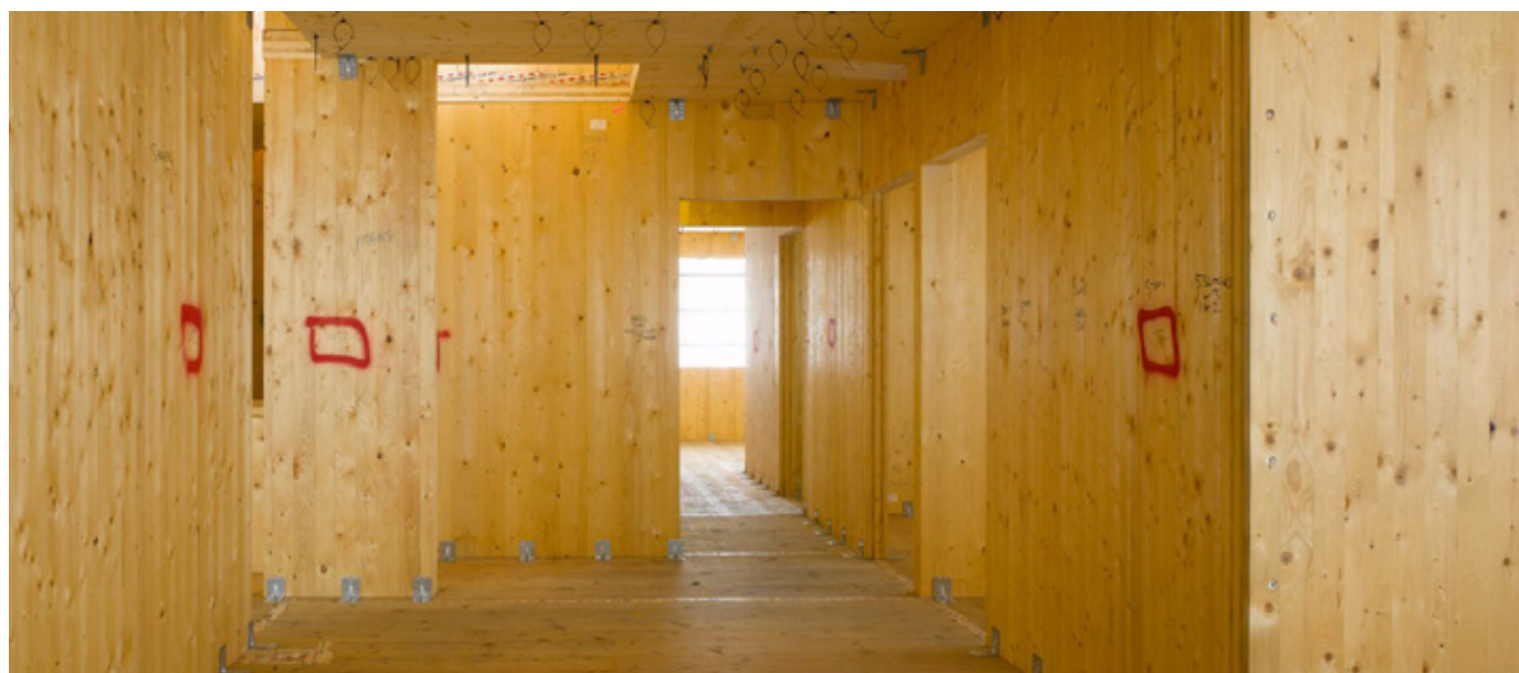
Figura 3.10 – Montaje de edificio Stadthaus, ejemplo de tipología paneles de madera masiva
