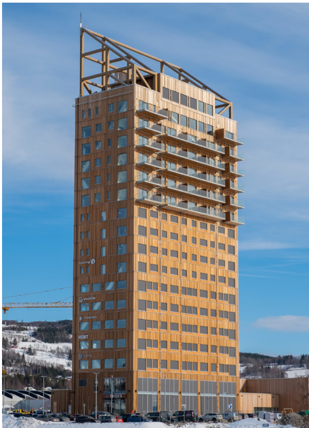
Figura 3.6 – Edificio Mjøstårnet, ejemplo tipología marco arriostrado Photo: © Moelven.
