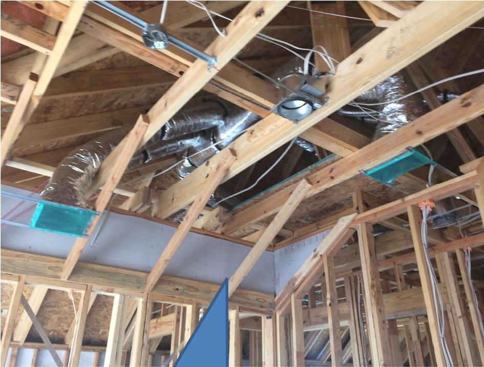
Fácil incorporación de sistemas de ventilación centralizada, para mantención de la calidad del aire interior (CAI)
