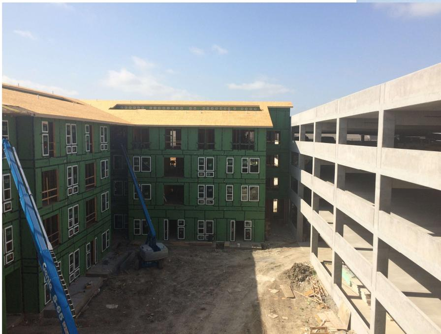
Edificio de viviendas en madera de 4 pisos de altura, con estructura de estacionamientos en hormigón.
