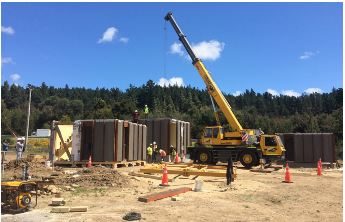
Figura 24. Montaje de módulos Torre Peñuelas
