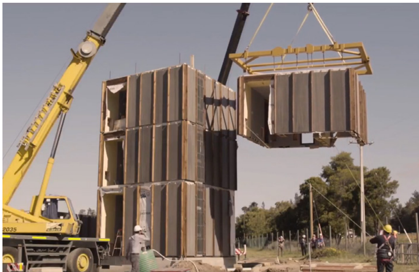
Figura 55. Izaje de módulo Torre Peñuelas
