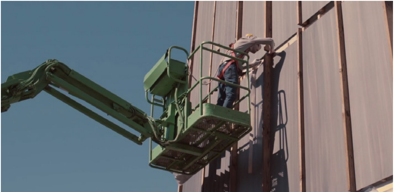
Figura 25. Mantenimiento de fachadas industrializadas
