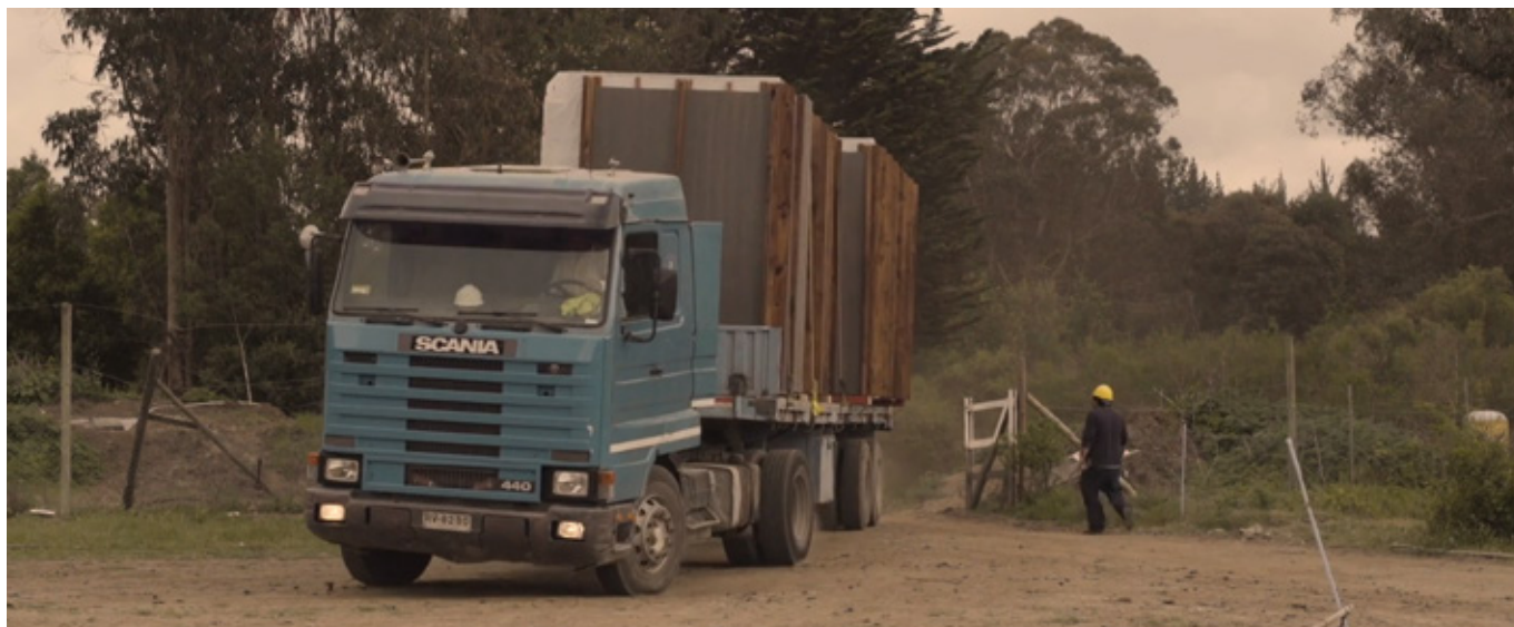
Figura 52. Transporte de módulo prefabricado
