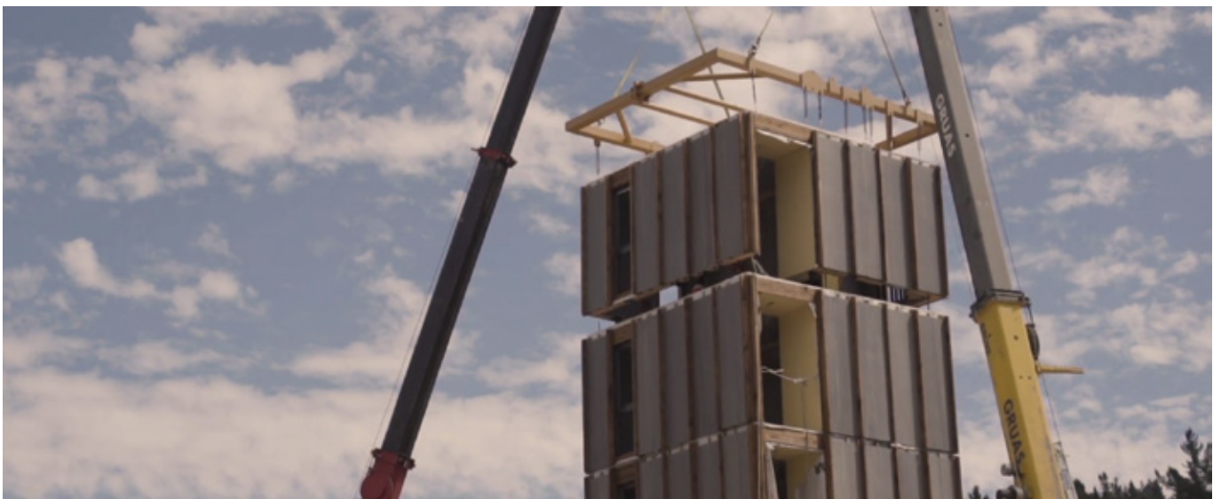
Figuras 57, 58 y 59. Izaje y montaje de módulos
