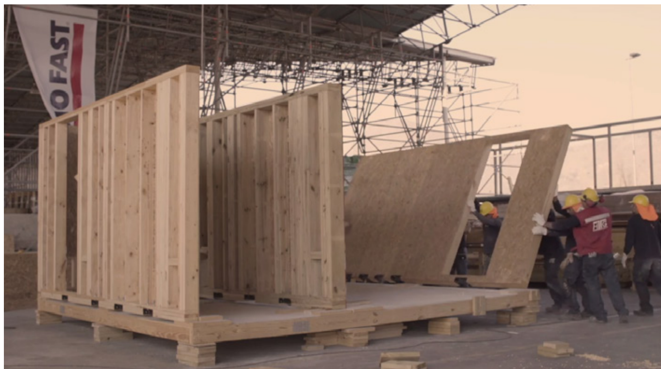
Figura 2. Montaje de módulo Torre Peñuelas en fábrica
