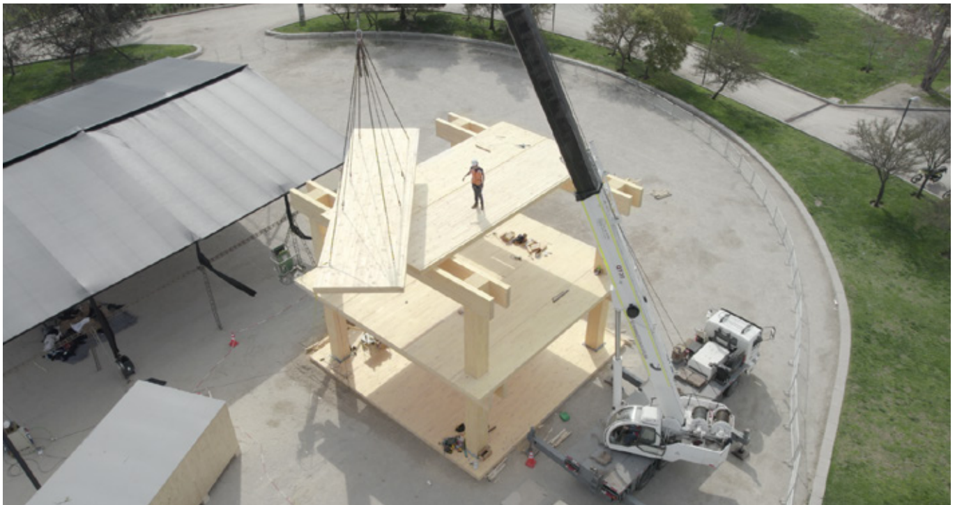
Figura 10. Proceso de montaje con CLT
