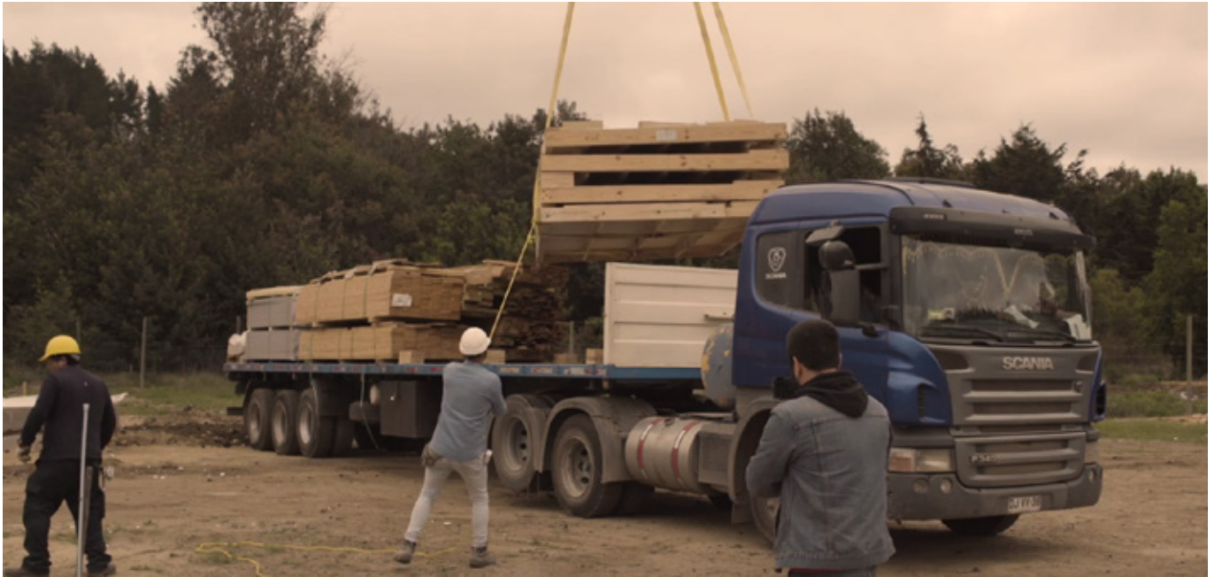
Figura 23. Transporte e izaje de elementos Torre Peñuelas
