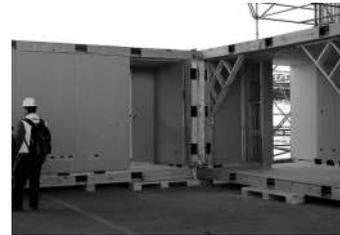
Fig. 3. Módulos revestidos con conectores metálicos (Peñaloza, 2018).
