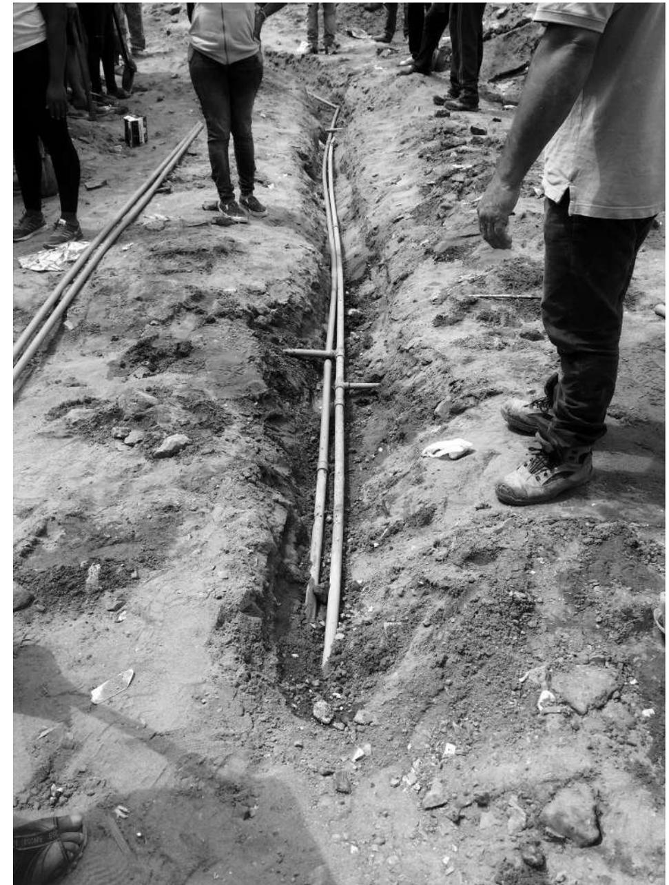
Fig. 2. Tuberías de PVC, canalizando agua a viviendas en el macro-campamento Los Arenales en Antofagasta, Chile (Bayer, 2018).
