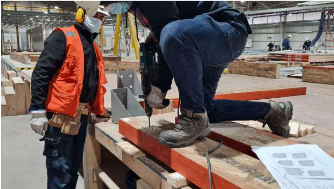
Figura 19. Proceso constructivo en planta de E2E.
