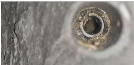
(g) Detalle conexión cabezal tornillo con placa interna de soporte 3D.
