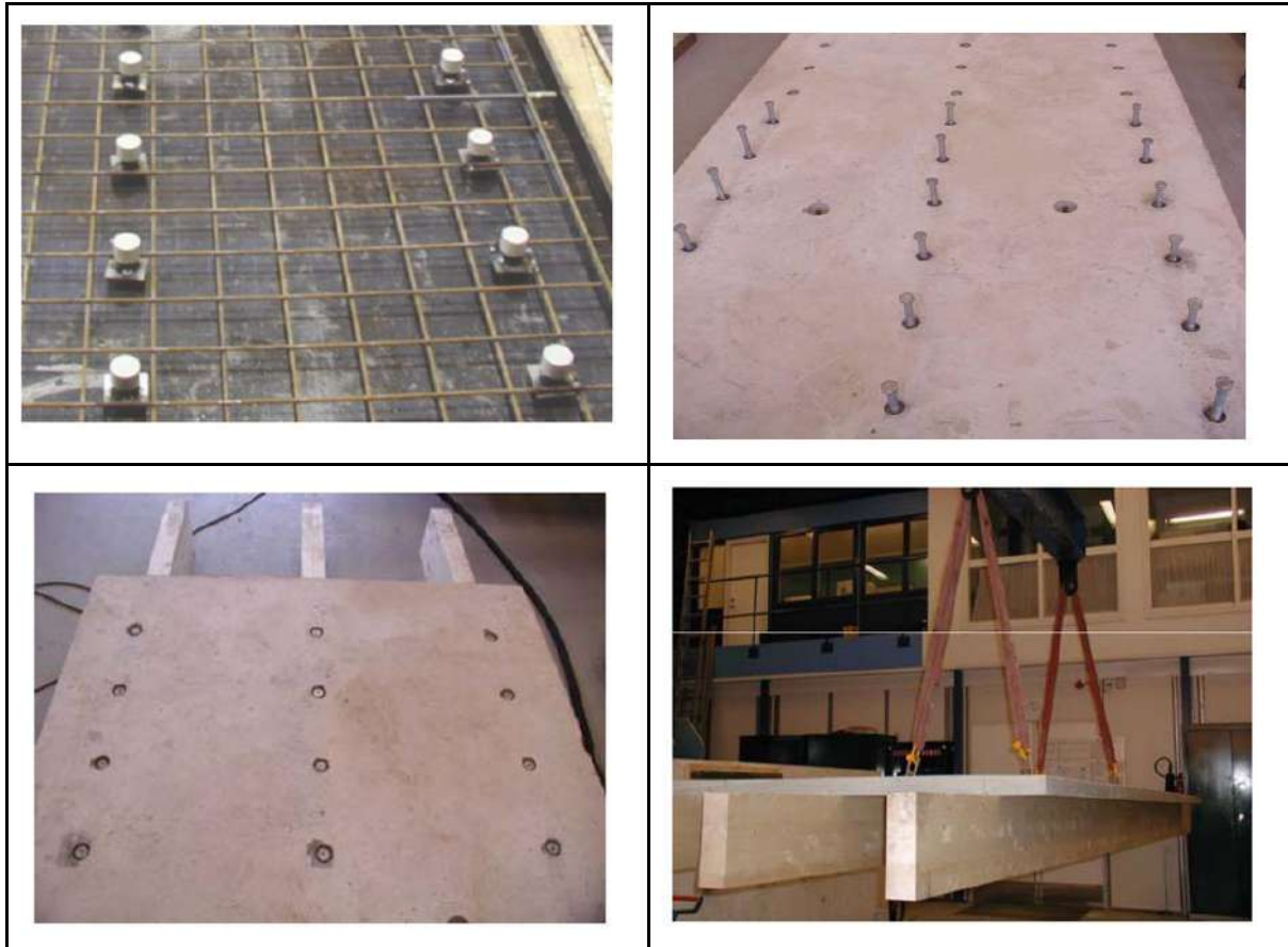
Figura 3.17. Losa prefabricada de hormigón. Fuente: Lukaszewska, 2010.
