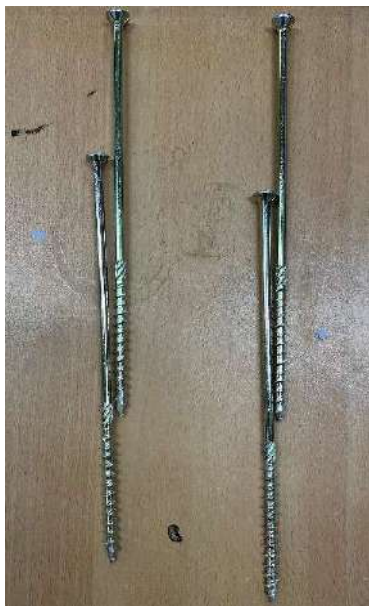
(e) Tornillos estructurales luego del fallo.
