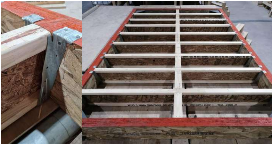
Figura 20. Vistas de marco desnudo con ensamblaje de vigas I-Joist y cadenas.
