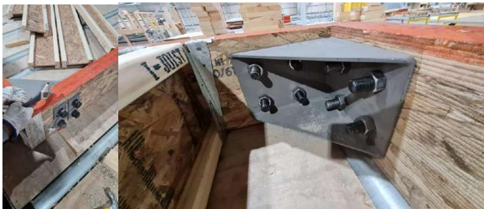
Figura 21. Vista de conexión apornada de esquina.
