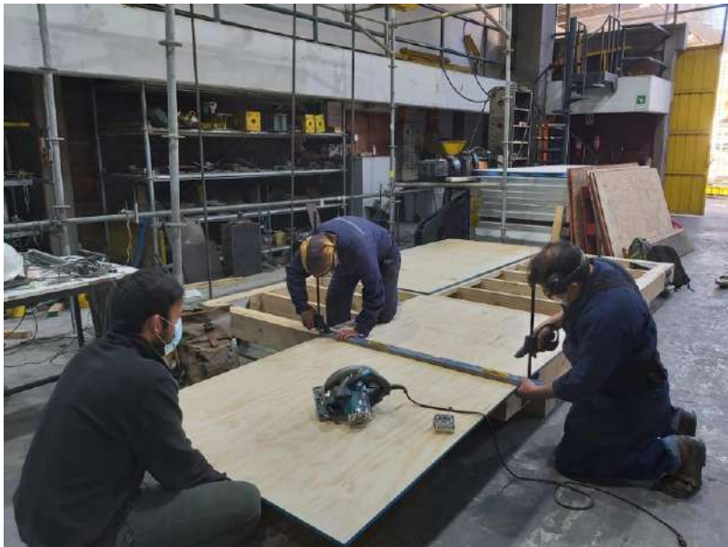
Figura 12. Proceso de arriostramiento de losas con tableros de terciado.
