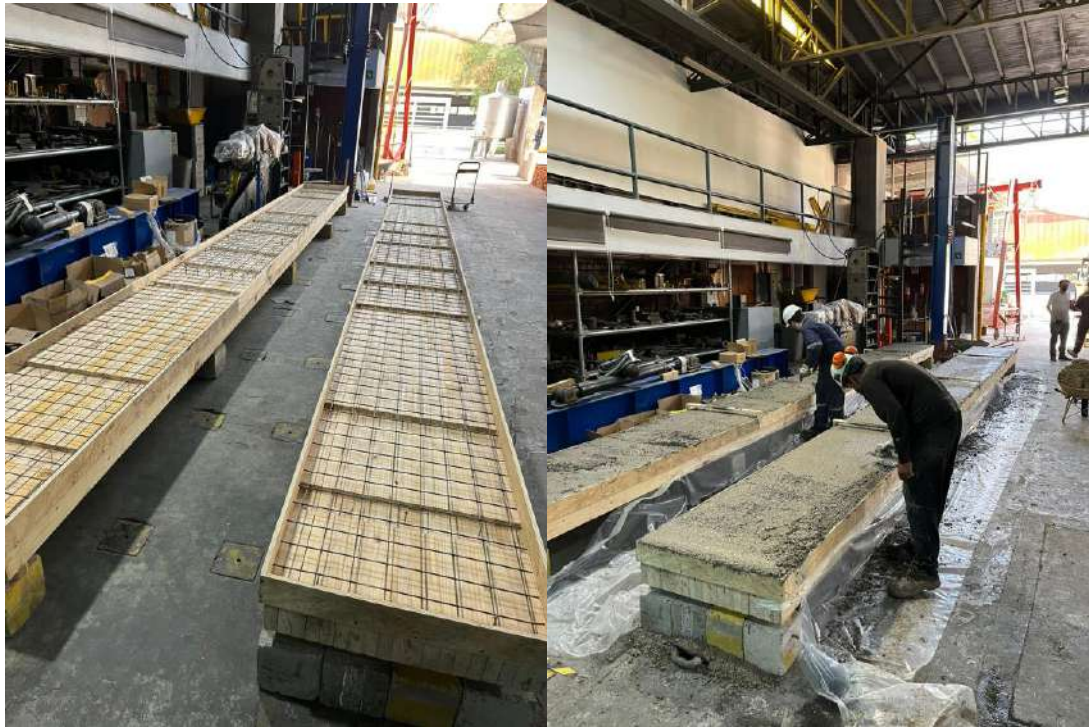
Figura 5. Proceso de fabricación probeta NLT Hormigonado sobrelosa.
